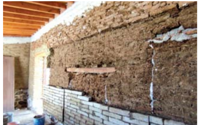
Εικόνα 9 Απόξεση του αποσαθρωμένου υλικού και πλήρωση με νέους ωμόπλινθους
