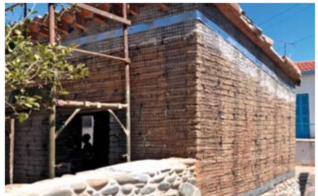
Εικόνα 10 Ενίσχυση της ωμοπλινθοδομής με χρήση συστήματος Ινοπλέγματος Ανόργανης Μήτρας (Textile Reinforced Mortar - TRM).
