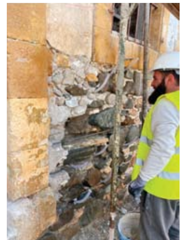
Εικόνα 6 Συρραφή ρωγμών με ράβδους ανοξείδωτου χάλυβα
