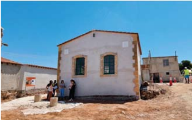
Εικόνα 11 Καθαρισμός περιβάλλοντα χώρου
