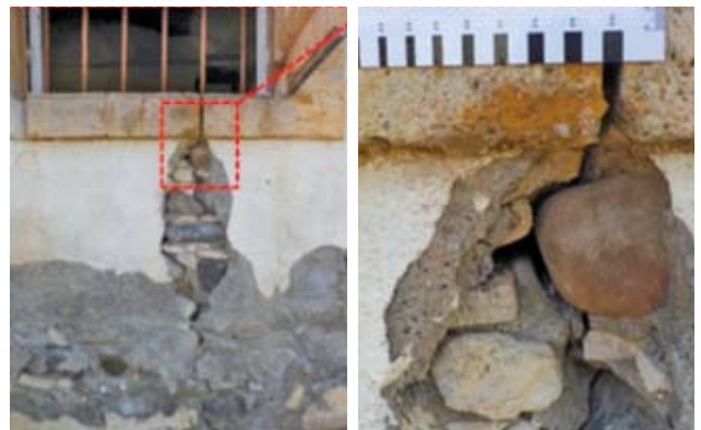
Εικόνα 3 Καταγραφή ρωγμών
