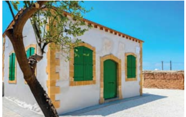
Εικόνα 12 Το Τζαμί αφού έχουν ολοκληρωθεί οι εργασίες αποκατάστασης
