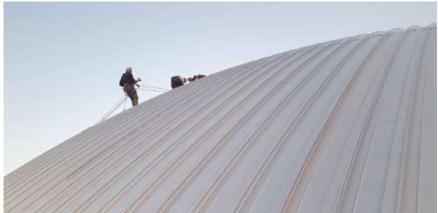
Εικόνα 11: Τοποθέτηση μεμβράνης στεγανοποίησης διπλής καμπυλότητας (Kalzip)
