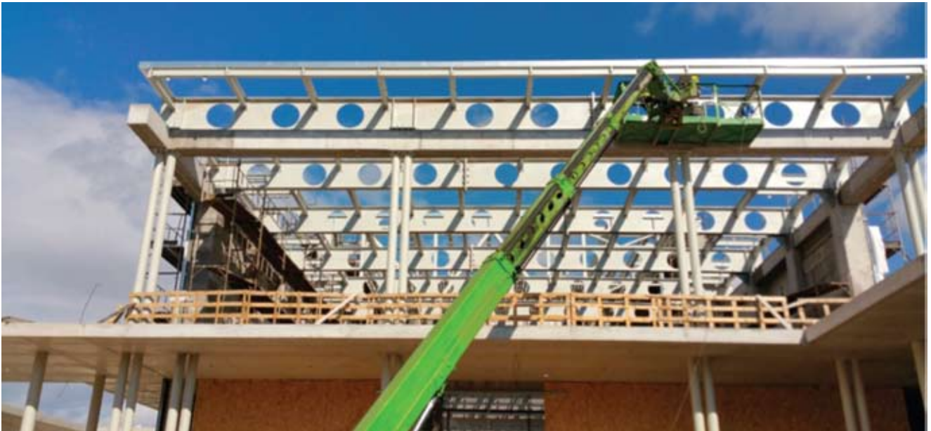
Τοποθέτηση μεταλλικών κυψελοειδών διατομών οροφής
