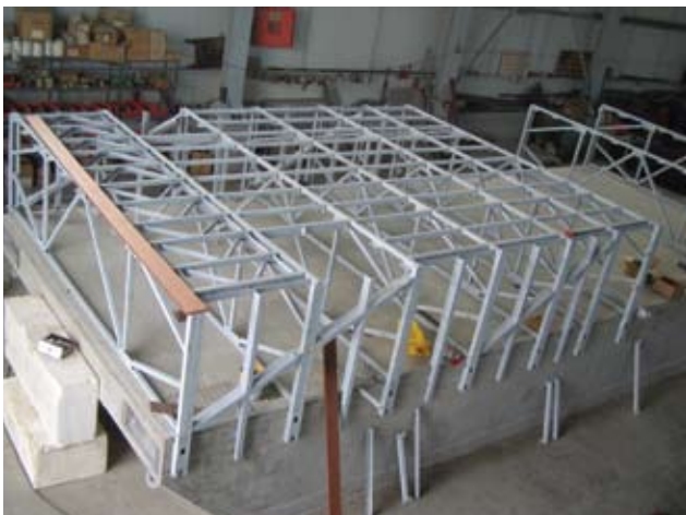
Σχ. 11-1 Το πλωτό κατά την κατασκευή του. Διακρίνεται η τυποποίηση
