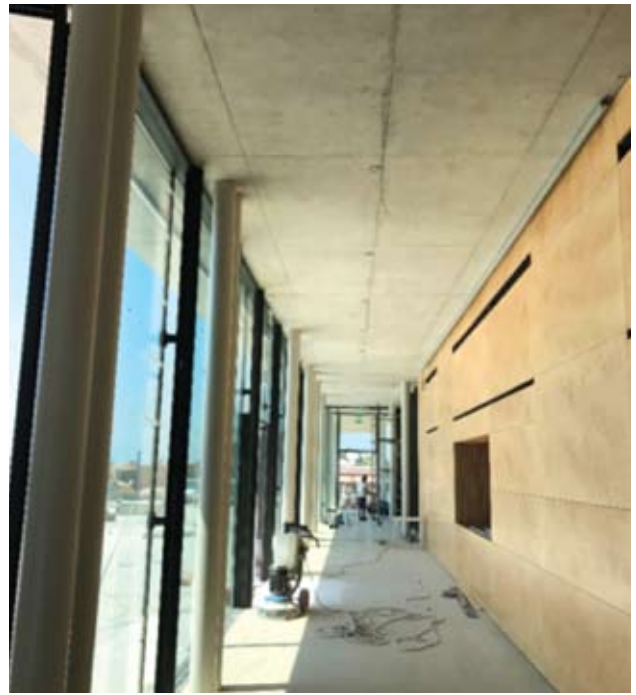
Είσοδος - Πλάκες εμφανούς σκυροδέματος επί σύμμικτων υποστρωμάτων
