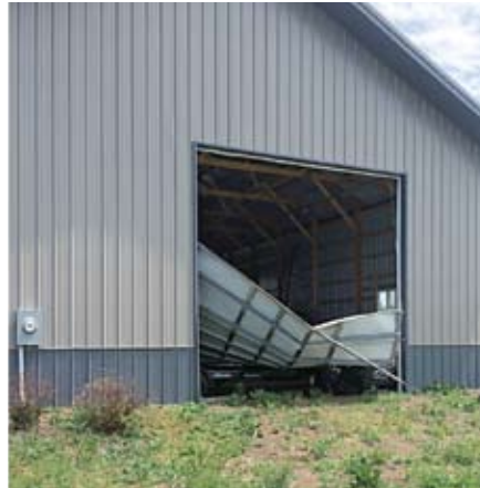
Οι εξώθυρες αποθηκών και χώρων στάθμευσης αποτελούν στοιχεία με μεγάλη επιφάνεια. Κατά συνέπεια, αναπτύσσονται επί αυτών ισχυρές ανεμοπιέσεις και προκαλούνται βλάβες και αστοχίες.
