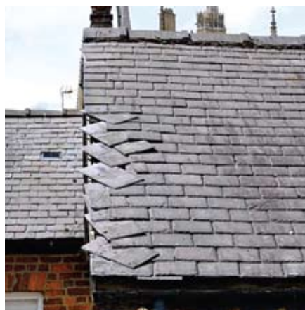
Οι ακμές της στέγης αποτελούν ένα από τα πιο ευπαθή σημεία της κατασκευής, λόγω της αλλαγής στην κίνηση του ανέμου, την οποία προκαλούν.
