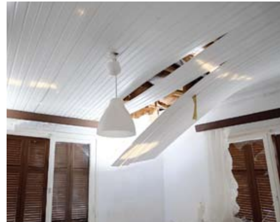
Η διείσδυση ισχυρού ανέμου στο εσωτερικό του κτιρίου συνοδεύεται από εκτεταμένες βλάβες (Χαλκιδική, Ιούλιος 2019).
