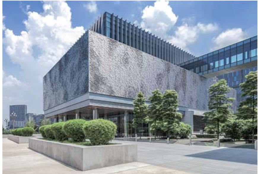
Η "E+C Facade" αποτελείται από χιλιάδες πτερύγια αλουμινίου, τα οποία κινούνται υπό την επίδραση των φυσικών φαινομένων παράγοντας ενέργεια, ενώ ταυτόχρονα ελαττώνουν το φορτίο ανέμου στην κατασκευή. © TECHNICAL.
