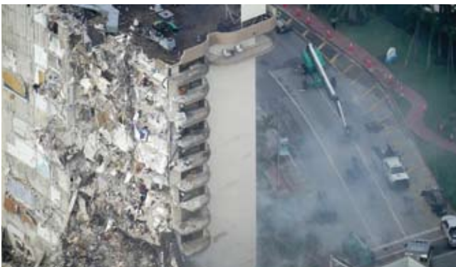
Φωτογραφία 3: Μερική κατάρρευση πολυώροφου συγκροτήματος κτιρίων στο Μαϊάμι της Φλόριντα,
