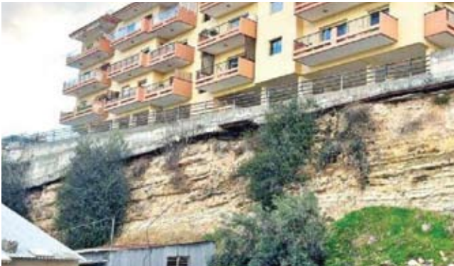
Φωτογραφία 1: Πολυκατοικία στην οδό Αγίου Ιλαρίωνα στη Γερμασόγεια
