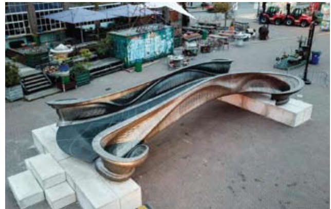
Σχήμα 1: Η τρισδιάστατα εκτυπωμένη μεταλλική «Γέφυρα MX3D» Πηγή: [5]
