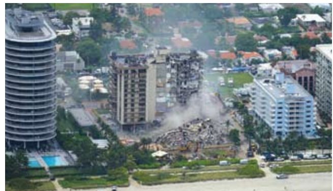
Φωτογραφία 4: Μερική κατάρρευση πολυώροφου συγκροτήματος κτιρίων στο Μαϊάμι της Φλόριντα
