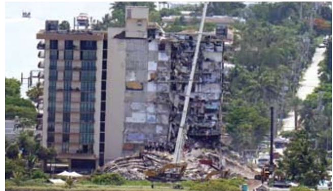
Φωτογραφία 2: Μερική κατάρρευση πολυώροφου συγκροτήματος κτιρίων στο Μαϊάμι της Φλόριντα,
