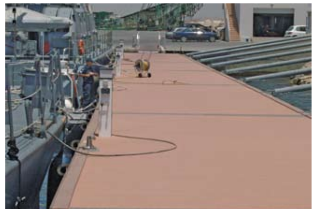
Το δάπεδο κυκλοφορίας, με τις αντιολισθητικές ραβδώσεις
