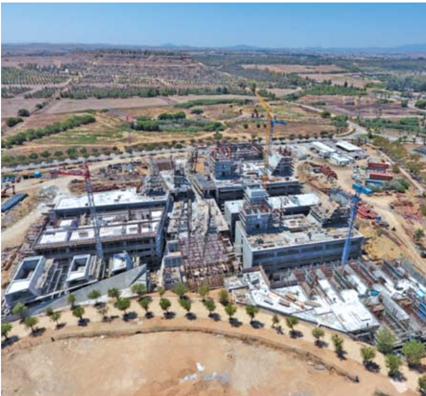
Εικόνα 5. Οι υπό ανέγερση νέες κτιριακές εγκαταστάσεις της Πολυτεχνικής Σχολής στην Πανεπιστημιούπολη του Πανεπιστημίου Κύπρου. (Φωτογραφία Αρχείου).
