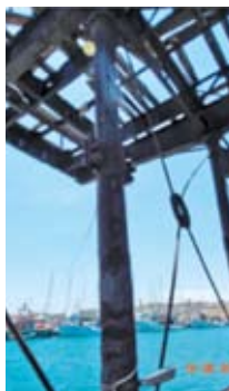
Σχήμα 13: Παραμορφωμένα διαγώνια μέλη και δοκοί και υποστυλώματα με απόκλιση από την κατακορυφότητα
