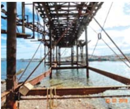
Σχήμα 13: Παραμορφωμένα διαγώνια μέλη και δοκοί και υποστυλώματα με απόκλιση από την κατακορυφότητα
