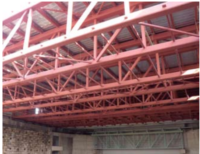
Σχήμα 1: Παράδειγμα μεταλλικού δικτυώματος (οροφή κτηρίου εκδηλώσεων).
