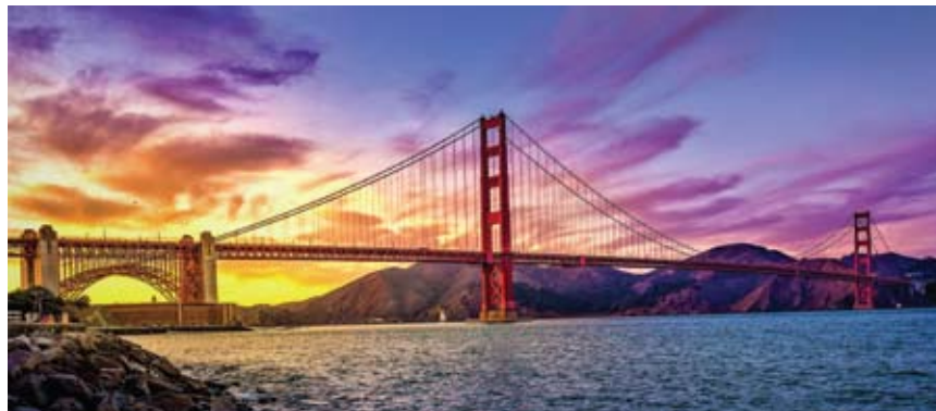
Εικόνα 1: Η γέφυρα Golden Gate στο Σαν Φρανσίσκο επικαλυμμένη με βαφή πλούσια σε ψευδάργυρο. Πηγή: Wikimedia commons.
