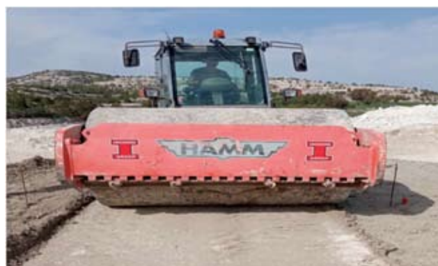
Φώτο 1. Συμπύκνωση σκληρού επιχώματος με δονητικό κύλινδρο
