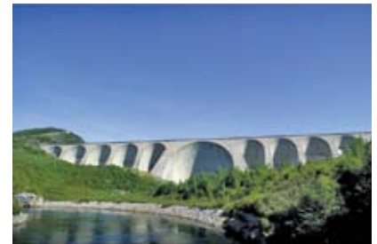
Φώτο 5. Φράγμα Daniel Johnson – Καναδάς – 213m ύψος - βαρύτητας με 13 αψίδες - 1968
