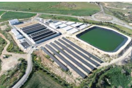
Σταθμός Επεξεργασίας Λυμάτων Άχνας
