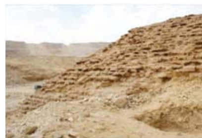
Φώτο 1. Φράγμα Saad El Kafara - Αίγυπτος 2900 π.Χ.
