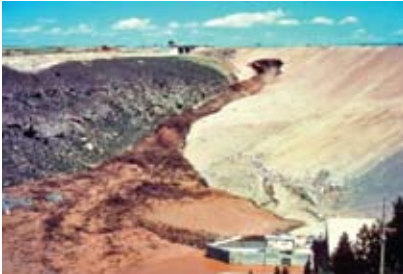
Φωτό 12. Φράγμα Teton - Εμφάνιση ροής θολού νερού στο δεξιό αντέρεισμα
