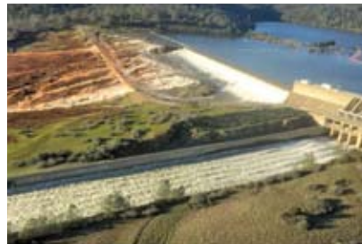
Φωτό 15. Φράγμα Oroville- Ταυτόχρονη ροή μέσω του υπερχειλιστή και του υπερχειλιστή έκτακτης ανάγκης
