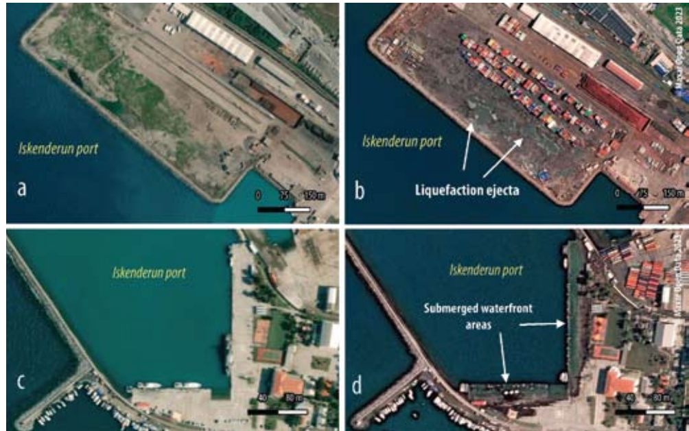
Εικόνα 2: Δορυφορικές εικόνες πριν από τον σεισμό (a, c) και μετά τον σεισμό που δείχνουν ρευστοποίηση εδαφών στις προβλήτες του λιμανιού του Iskenderun (b) και καθίζηση εκτεταμένων τμημάτων του παραλιακού μετώπου (d) (Taftoglou et al. 2023)
