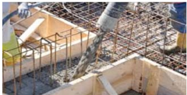
Σχήμα 6: Σκυροδέτηση με διάστρωση νωπού σκυροδέματος μέσω αντλίας μπετού.
