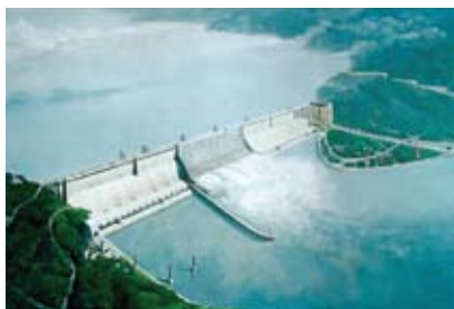
Φώτο 8. Φράγμα Three Gorges – Κίνα 181m ύψος, 22.500MW – 2006
