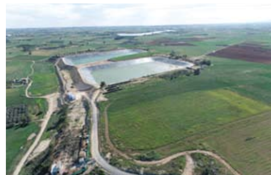
Δύο Δεξαμενές αποθήκευσης επεξεργασμένου νερού & το αρδευτικό Αντλιοστάσιο
