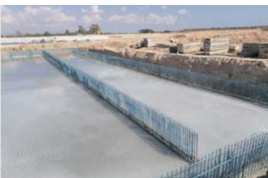
Κατασκευή θεμελίου δευτεροβάθμιων δεξαμενών
