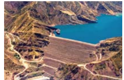
Φώτο 7. Φράγμα NUREK – Τατζικιστάν – 300m ύψος – Χωμάτινο - 1972
