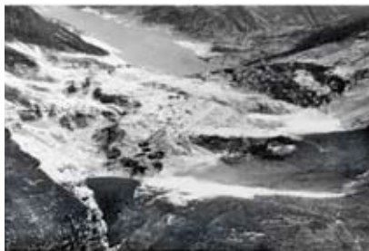
Φώτο 10. Αεροφωτογραφία που δείχνει την κατολίσθηση στο αριστερό αντέρεισμα του ταμειυτήρα του φράγματος Vajont
