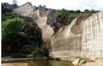
Φώτο 9. Το καταστραμμένο φράγμα Malpasset (φωτογραφία 2014)
