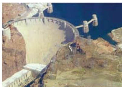
Φώτο 4. Φράγμα Hoover-ΗΠΑ-221 m ύψος-τοξωτό / βαρύτητας-1936
