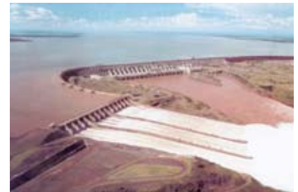
Φώτο 6. Φράγμα ITAIPIU- Βραζιλία/Παραγουάη - 196m ύψος – 14.000MW – 1984
