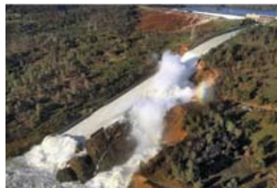
Φωτό 14. Φράγμα Oroville - Ζημιά στον υπερχειλιστή του φράγματος
