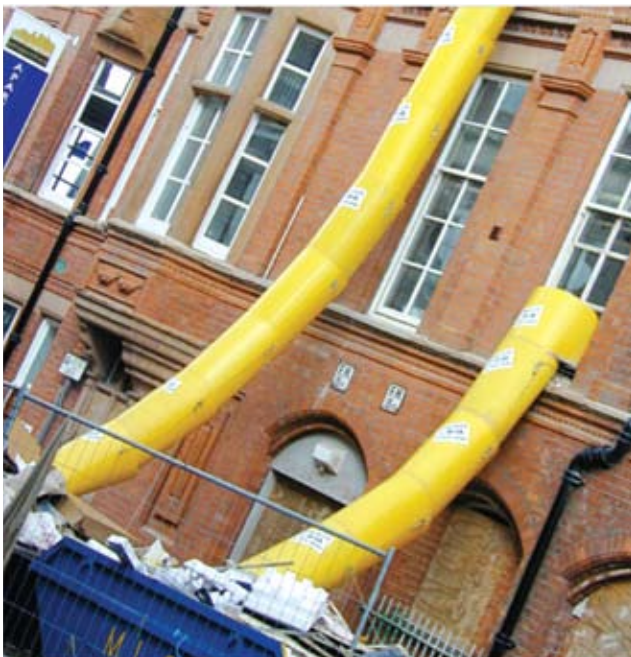
Εικ. 3: Πλαστικοί αγωγοί απομάκρυνσης υλικών ανακύκλωσης. Πηγή 6
