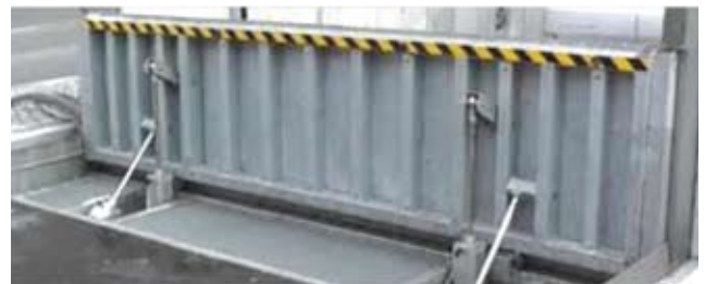
Εικόνα 4 Παράδειγμα μηχανοκίνητου φράγματος (piston operated)
