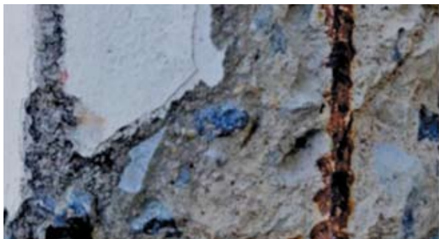
Σχήμα 4: Ταυτόχρονη ενανθράκωση και διάβρωση του χαλύβδινου οπλισμού [11].
